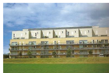
L'immeuble Salvatierra, à Rennes : le prototype français d'immeuble écologique, remarquablement bien isolé, sobre en énergie, exposé au sud, équipé de capteurs solaires et construit au moyen de matériaux locaux économes en énergie grise (terre et bois). Une initiative remarquable qui n'a hélas été suivie d'aucune descendance...
